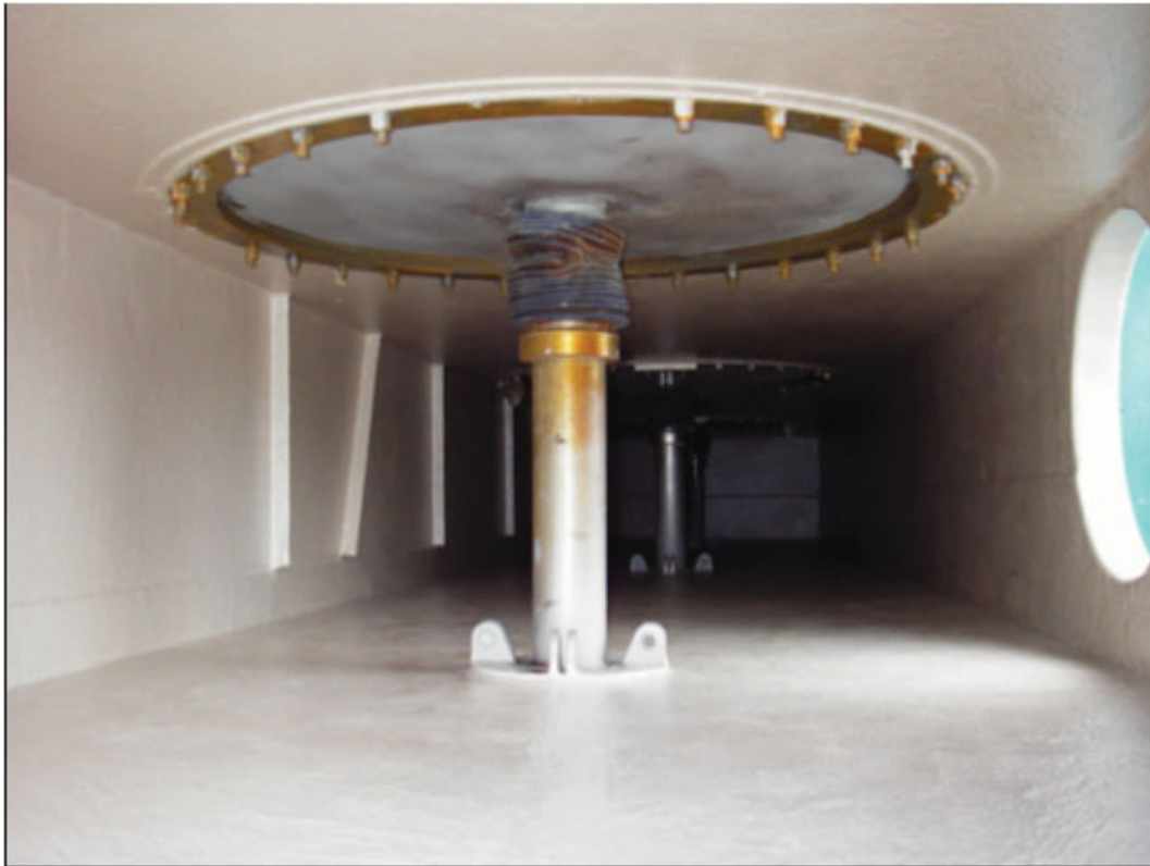
Abbildung 5: überarbeiteter Rohgaskanal
