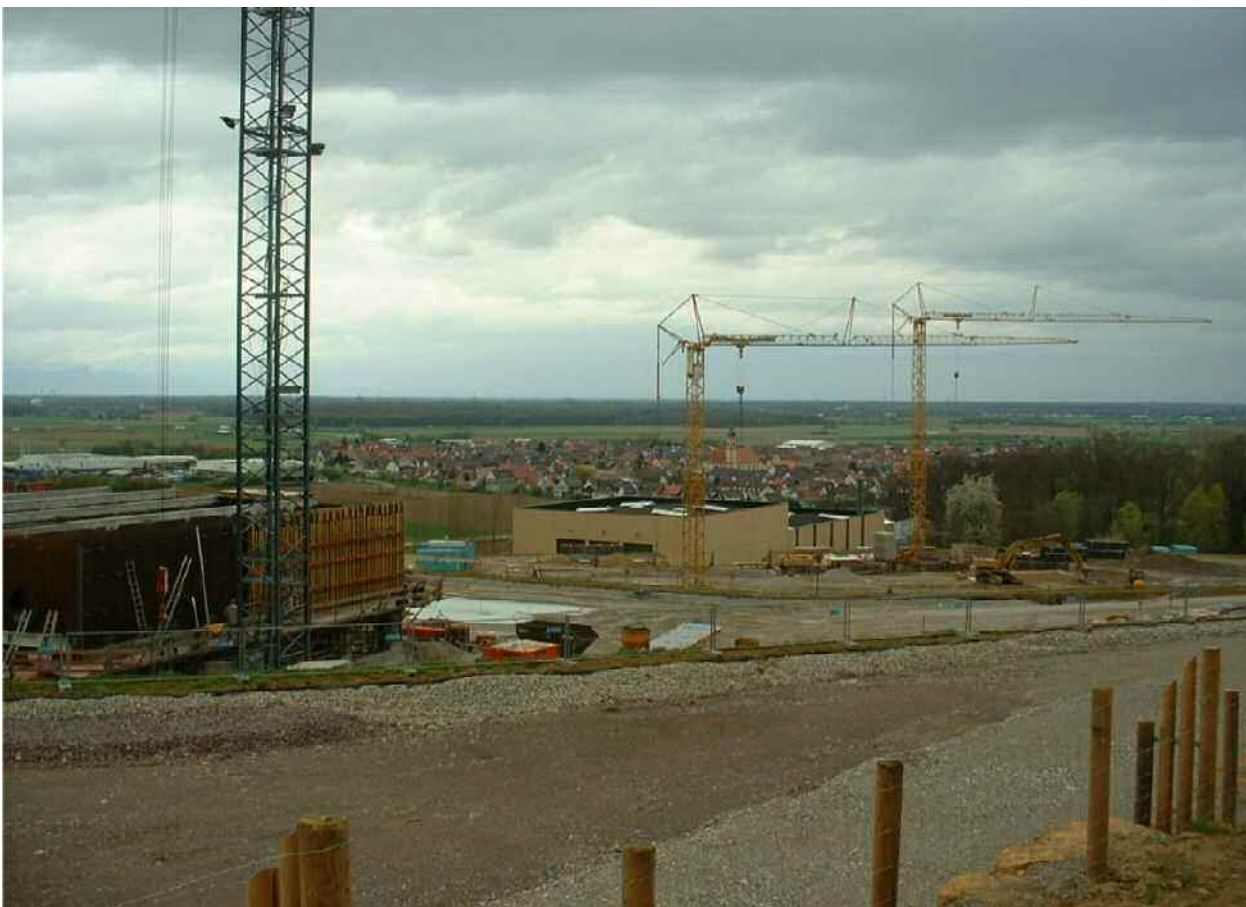
Abbildung 11 Bau der Perkolatoren (links) und Geländeprofilierung, Februar 2005
