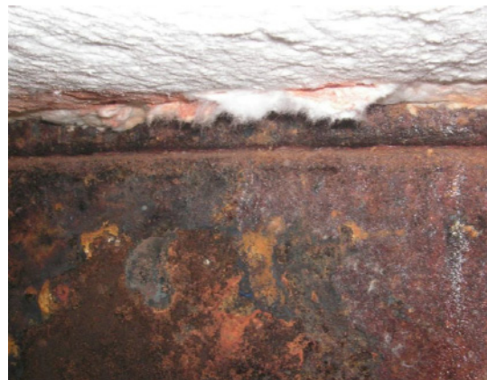
d) Brennkammerwand (innen)
