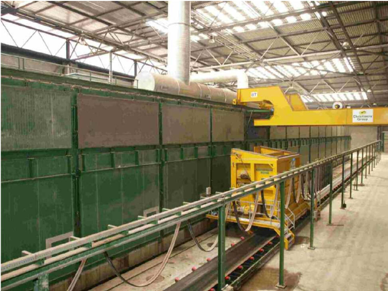
Abbildung 12 Rottetunnel MBA Villena
