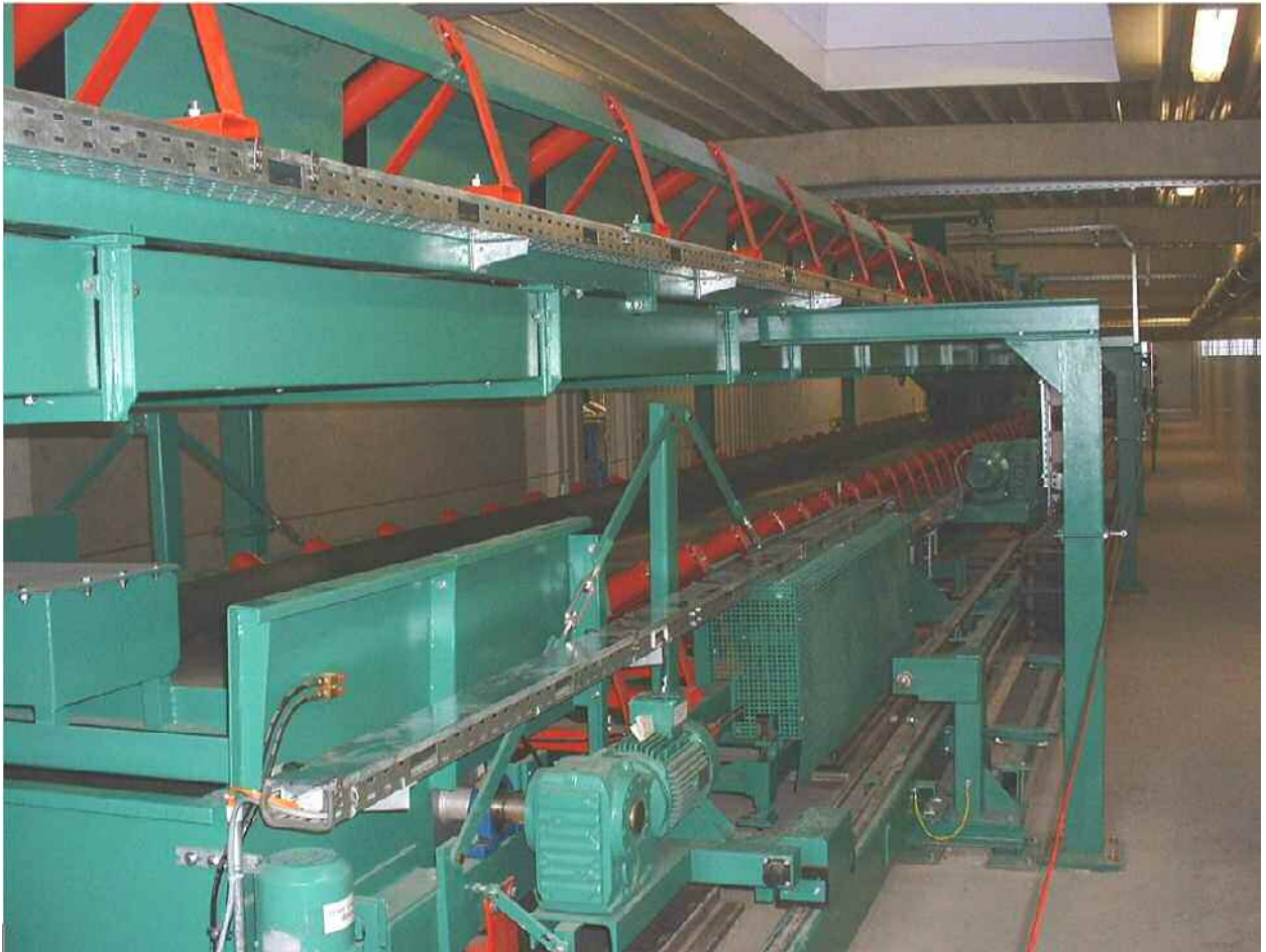
Abbildung 7 Fördersystem auf dem Tunneldach
