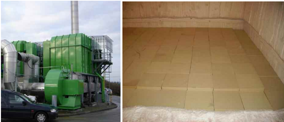
Abbildung 9 RTO in Stralsund und zusätzliche Schicht Wabensteine
