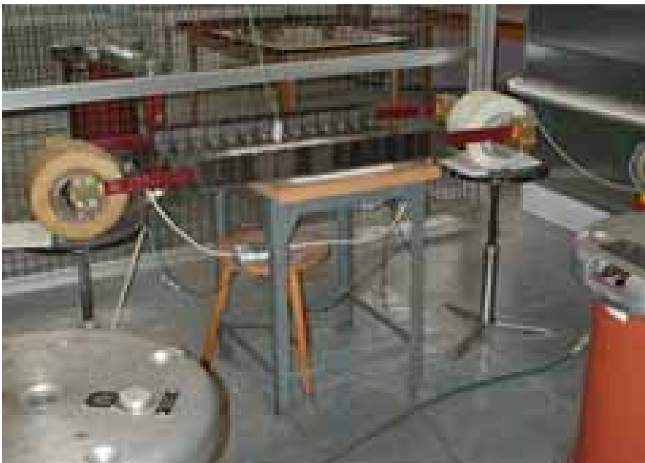
Bild 2.3: Foto der Einrichtung zur Stromheizung der Statorstäbe
