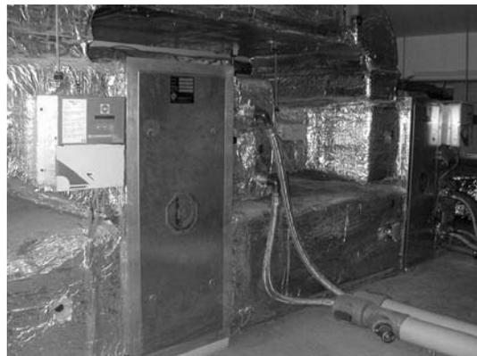
**Abbildung 5.6:** Seitenansicht der ausgeführten sorptiven Lüftungsanlage (oben Konstruktionszeichnung, unten Fotos)
