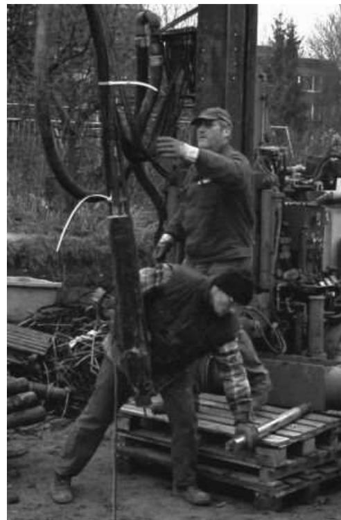
Abbildung 5.8: Einsetzen der Erdkältesonden für die Demonstrationsanlage
