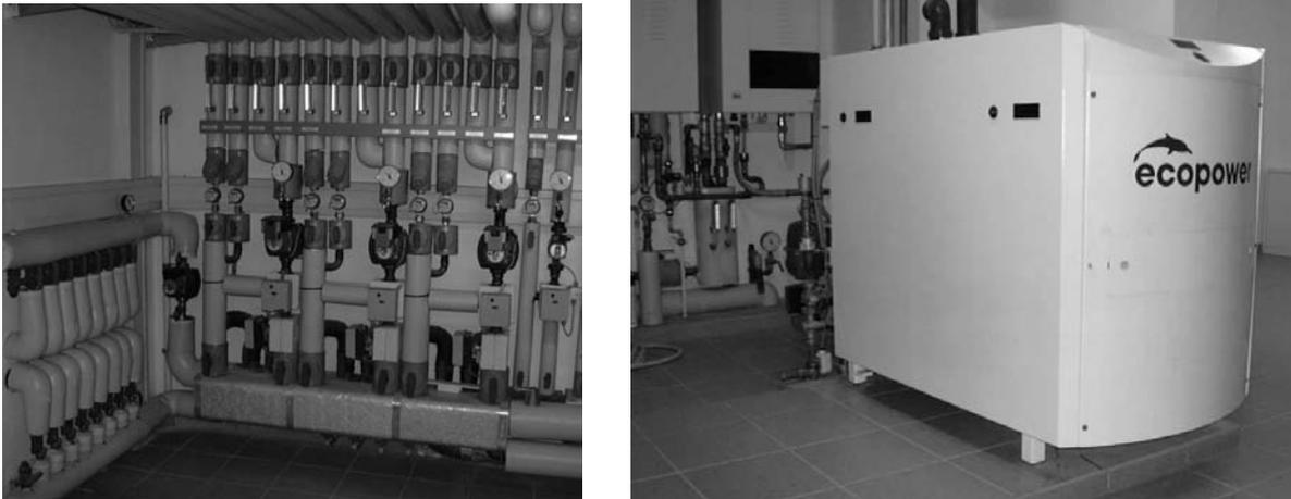
**Abbildung 5.5:** Links: Rohrleitungen der Erdkältesonden (unten links) und Fußbodenheizkreise, rechts: Blockheizkraftwerk der Fa. Ecopower
