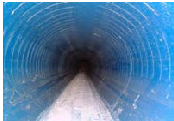
Bild 5.13 Phase A, Rohr unkonditioniert
