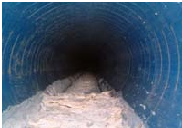
Bild 5.12 Phase A, Rohr konditioniert
