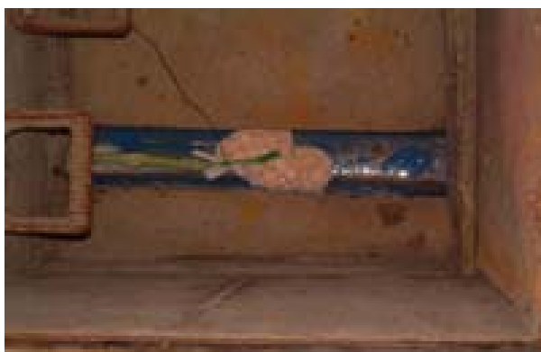
Bild 5.7 Aufbausituation Schacht 136 R
