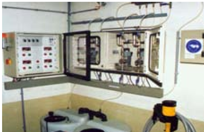
Bild 2.12 Dosierpumpe mit Vorratstank im Einsatz [54]
