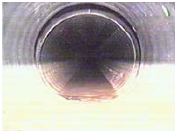
Bild 6.1: vertikaler Rohrversatz an einem Rohrstoß
