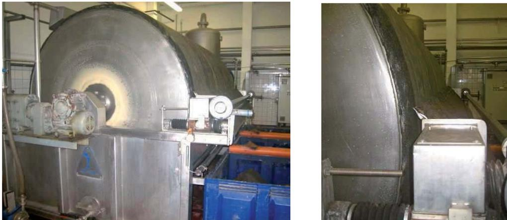
**Abbildung 2-7** Vakuum-Drehtrommelfilter
