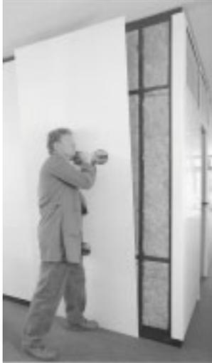
Montage einer Elementmetallwandschale auf die Unterkonstruktion
