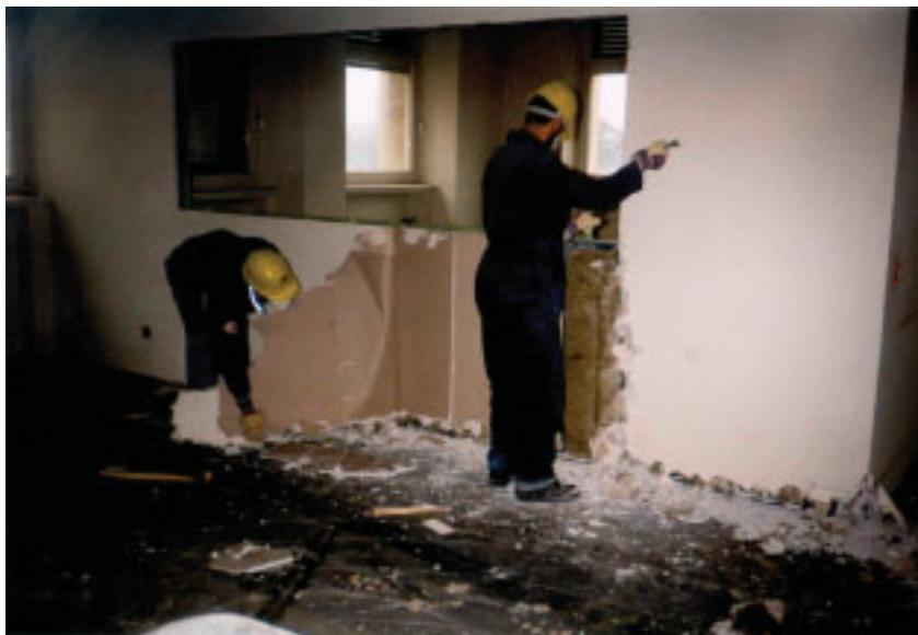
Abbildung 63 Rückbau einer Gipskartonständerwand des Systems 2
