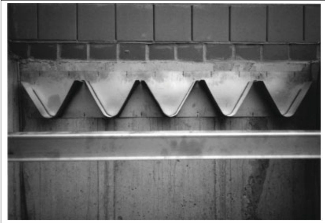
Abb. A.12: Spülrinnen: Rinnenauflage (Innenwand) und Unterzug
