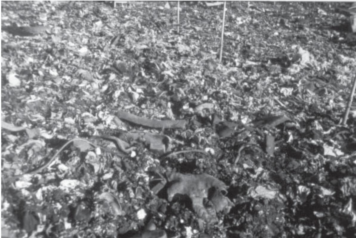
Foto 1: Abfalloberfläche ungesiebter mechanisch-biologisch behandelter Abfälle nach dem hochverdichteten Einbau mit dem Kompaktor
