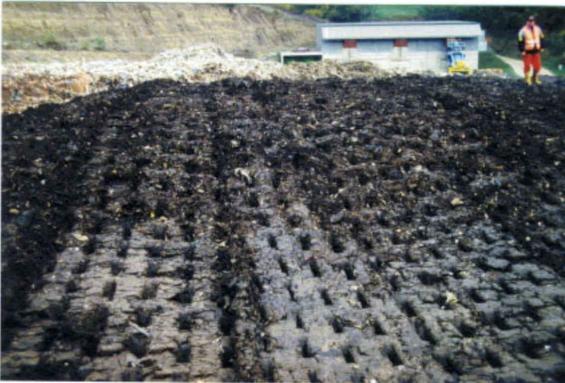
Foto 3: Abfalloberfläche nach der Verdichtung mit dem KAELBLE- Kompaktor (28 t )
