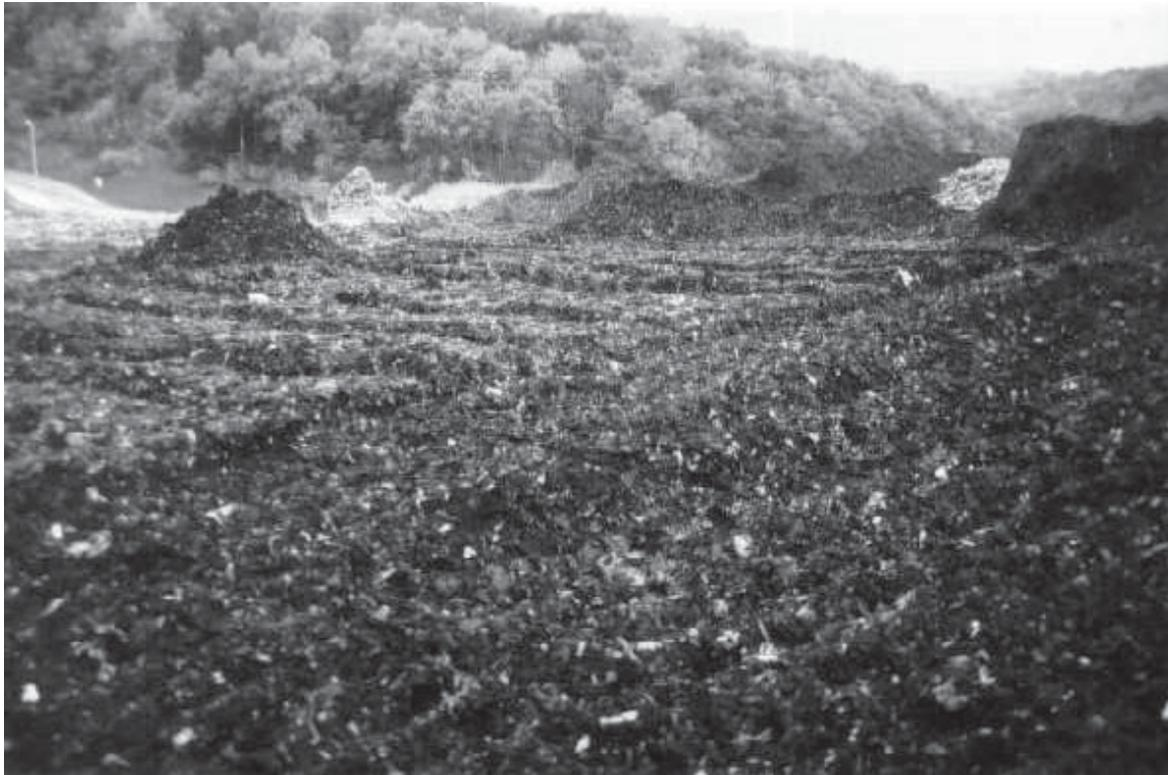
Foto 2: Abfalloberfläche nach der Verdichtung mit dem BOMAG-Kompaktor (40 t )
