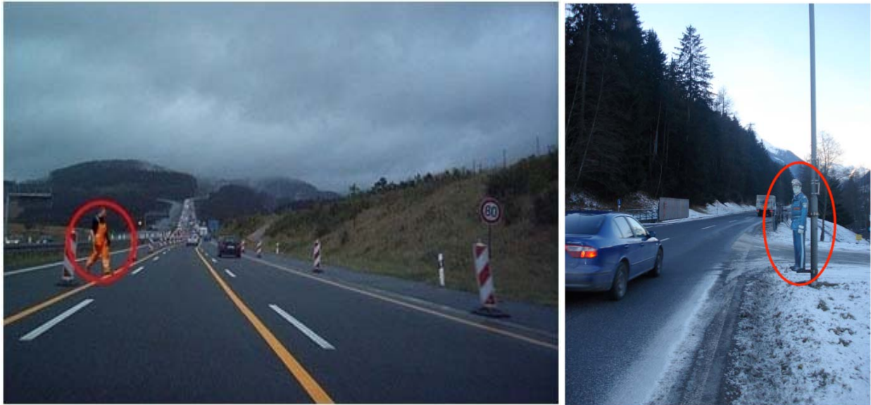
Abb. 53: Beispiel für menschenähnliche Attrappen (siehe roter Ring) auf der Autobahn und auf der Landstraße.
