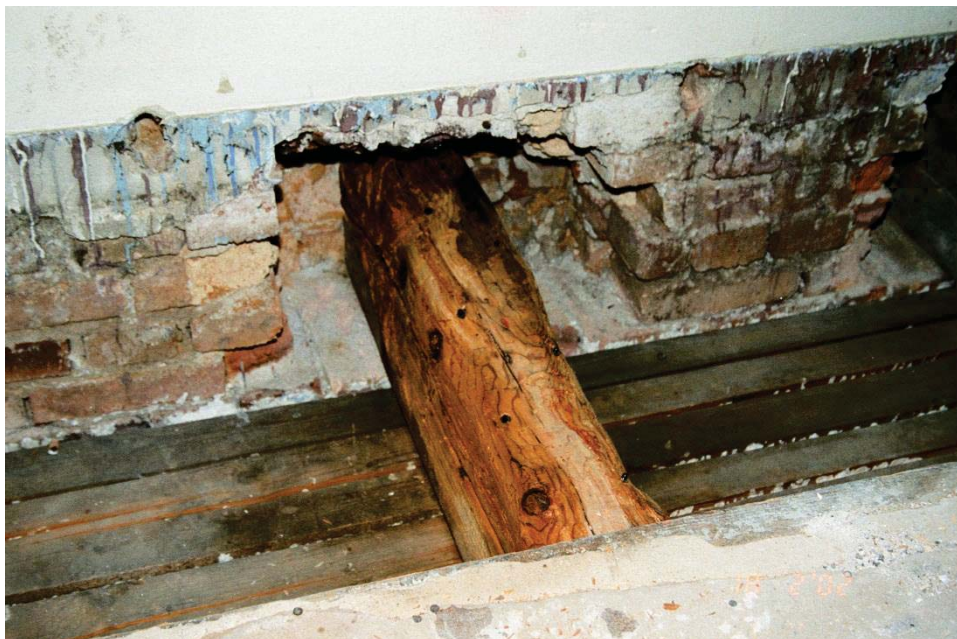
Abb. 3: Bei einer oberflächlichen Nassfäuleschädigung kann der Balkenkopf nach Bebeilung und Imprägnierung erhalten werden. Dazu ist eine umfassende Freilegung notwendig.
