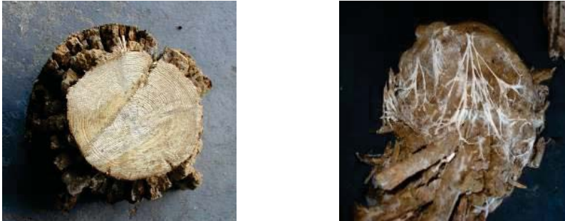
Abb. 3: Mast mit stark zerstörtem Splintholzbereich (links) und mit Befall des Kern- und Splintholzes (rechts)
