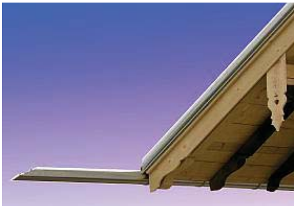
Abbildung 2: historischer konstruktiver Holzschutz im Dach- und Pfettenbereich
