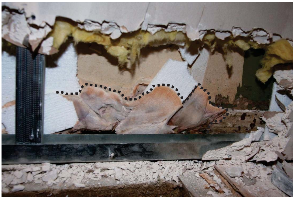
Abb. 1: Am Dämmmaterial (Polystyrolhartschaum) in einer Trockenbauwand ist deutlich die Wachstumsgrenze des Echten Hausschwamms zu erkennen.
