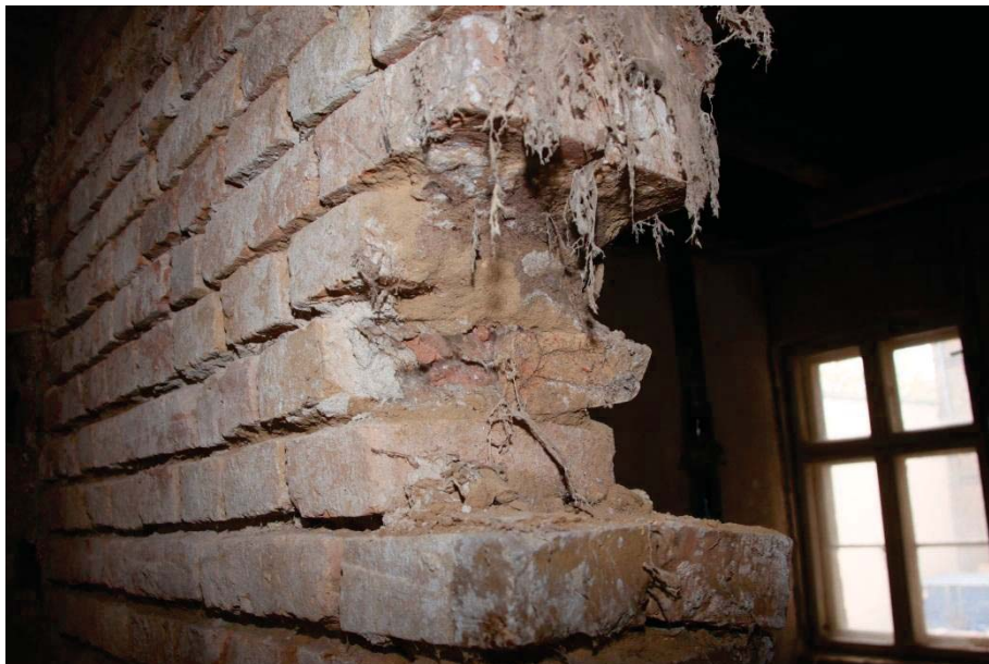
Abb. 2: Das beidseitige Auskratzen von festem Fugenmörtel an einer 24er Mauerwerkswand kann zu erheblichen Gefügezerstörungen führen und hat zu unterbleiben.
