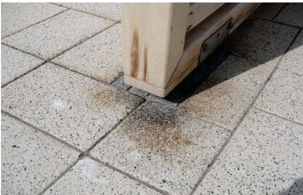
Abb. 17: Braune Farbausläufer Accoya
