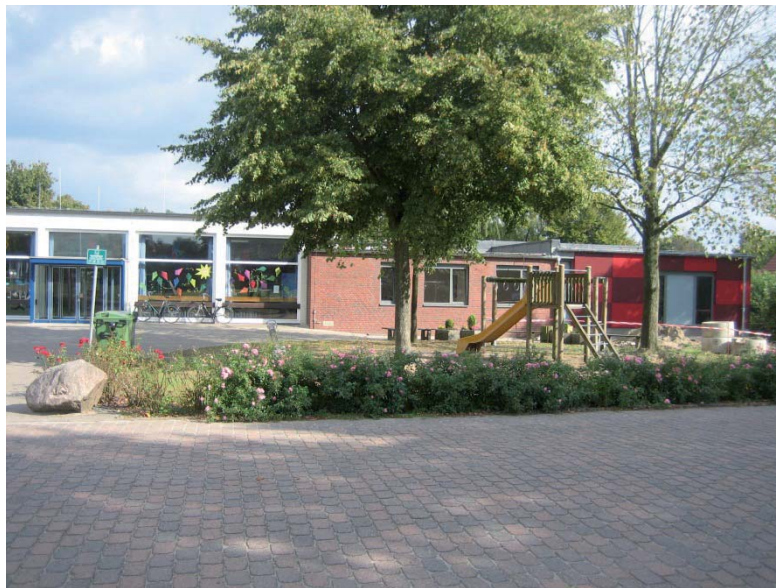
Abbildung 6.1: Photo der Grundschule (Fallstudie)
