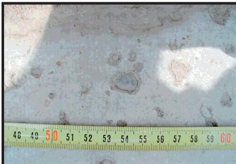
C: Abwitterungen einen dünnen Zementmörtelschicht über Gesteinskörnung
