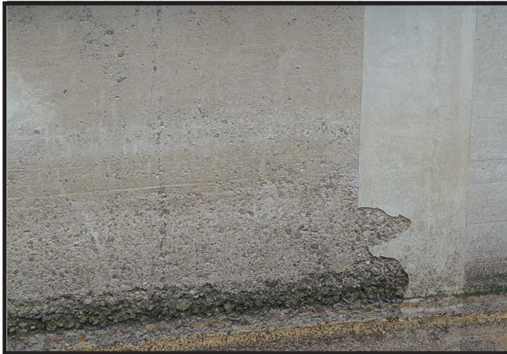
**Abbildung 2.2:** Äußere Schädigung in der Wasser-Wechsel-Zone eines Kläranlagebeckens nach acht Jahren Nutzungsdauer; entnommen aus [Aub06].
