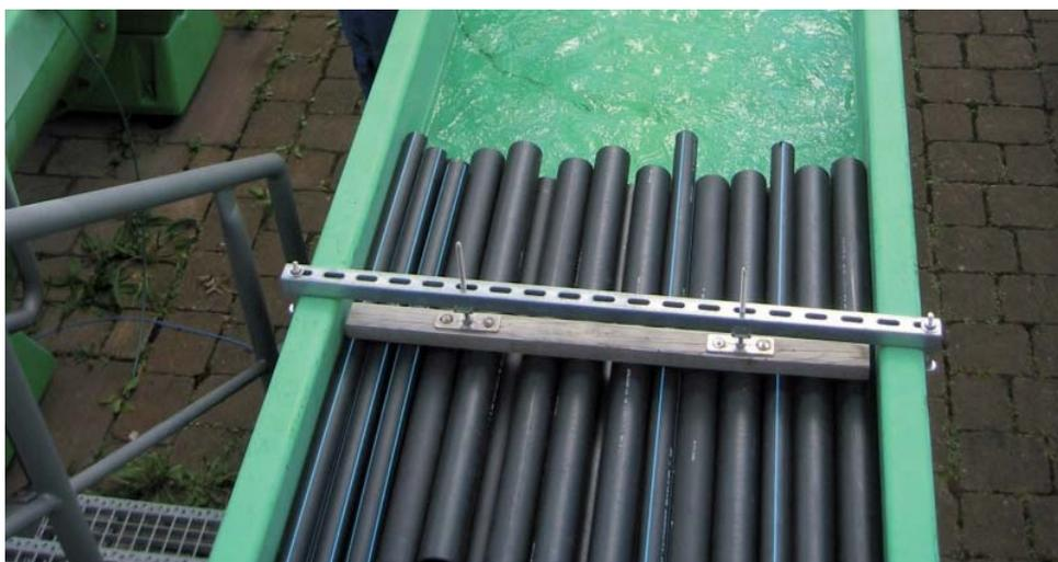
**Abbildung 3:** Gleichrichterrohre hinter der Schneckenpumpe. Links die Online-Messtechnik, die durch ein verschiebbares Blechdach vor der Witterung geschützt werden kann (Foto von Michael Feibicke, UBA)
