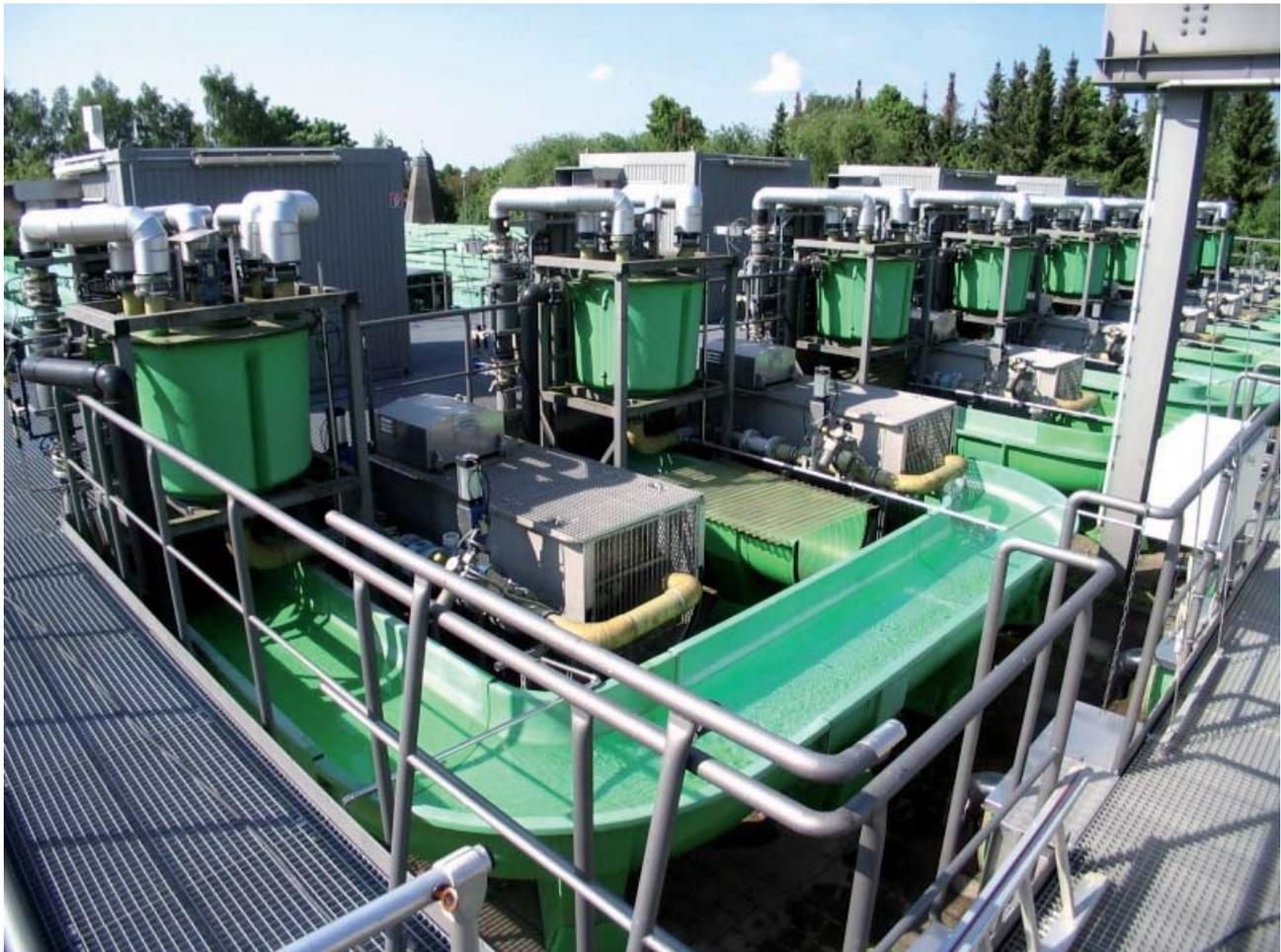
**Abbildung 6:** langer Bogen der Kombi-Rinne. In einer Reihe die ebenfalls grünen Vorlagebehälter und rechts daneben in Gitterkäfigen die Schneckenpumpen (eigenes Foto)
