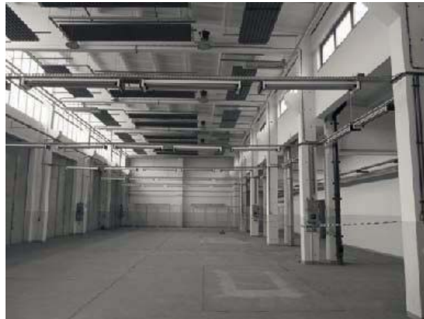
Abb. 5.4 Innenansicht Halle 125 August-Bebel-Str.32, Dresden
