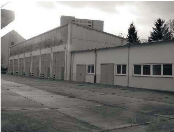
Abb. 5.3 Außenansicht Halle 127, August-Bebel-Str.32, Dresden
