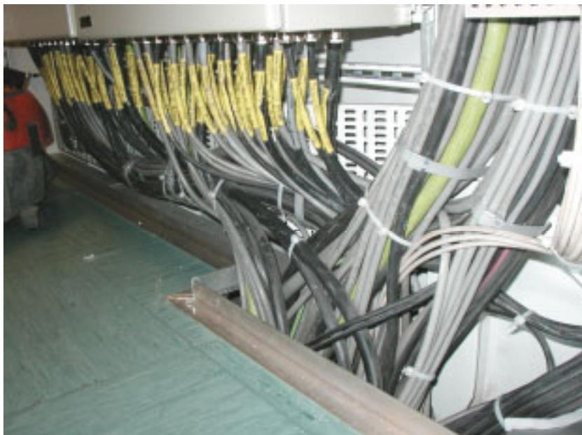
Abbildung 2.4: Kabelstränge in einem hinter der Brücke liegenden Elektronikraum. Die Kabel führen über den doppelten Boden bzw. über die Decke zu den Anzeigen und Systemen auf der Brücke sowie zu weiteren Elektronikräumen im Deck unterhalb der Brücke.
