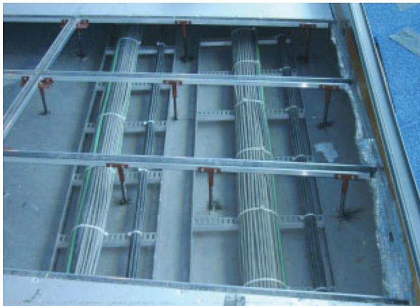
Abbildung 2.5: Kabelverlegung in getrennten Kabelbäumen im doppelten Boden unterhalb der Schiffsbrücke. Die Kabel werden in kurzen Abständen durch Kabelschellen gegen Verschieben gesichert.
