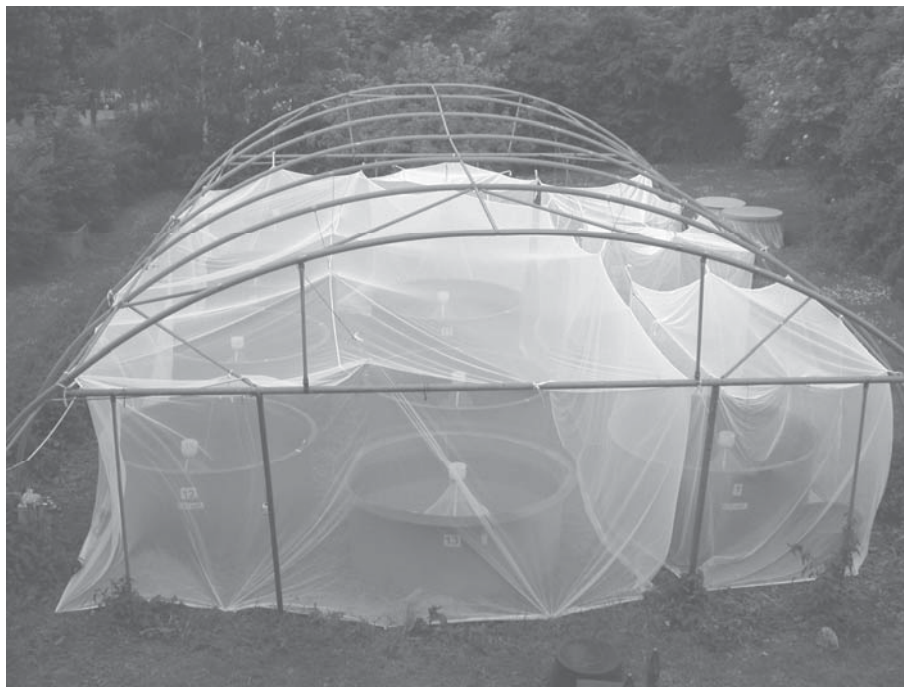
Abbildung 3-10: Aufsicht auf die Mesokosmosanlage nach der Netzinstallation (Süd-Westansicht)
