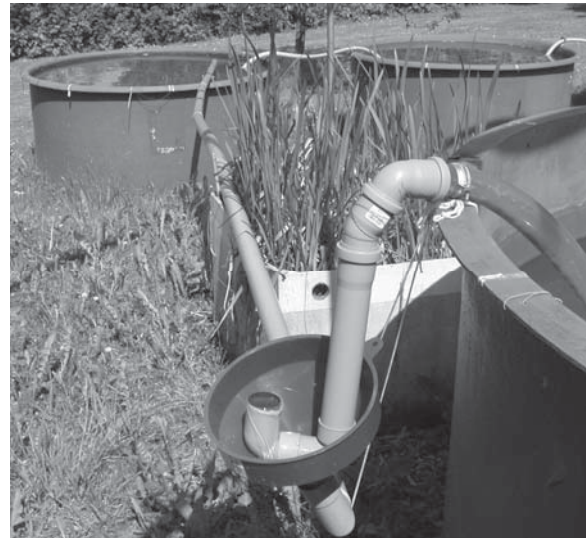
Abbildung 3-6: Überlauf mit Trichter und Verbindungsrohr zu den tiefer gelegenen Teichen
