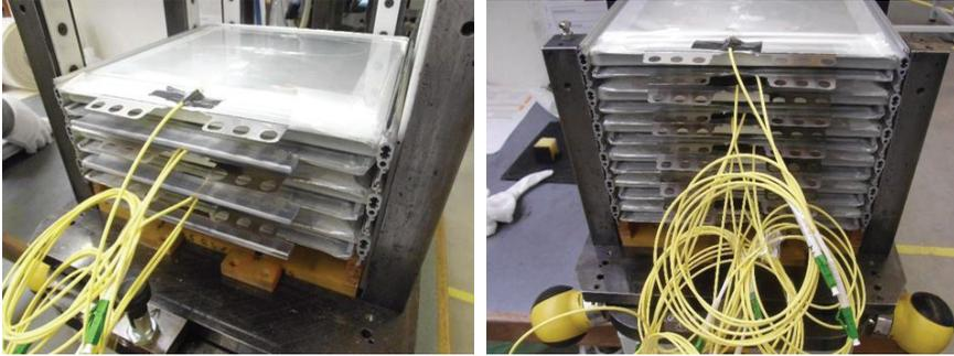
**Abbildung 1.21:** Stapelvorgang beim Aufbau eines Batteriemoduls nach dem Zusammenstecken von drei der sechs Doppelpaare (links) und die fertig gestapelte Bi-Packs eines Batteriemoduls vor dem Verkleben und Verpressen (rechts)
