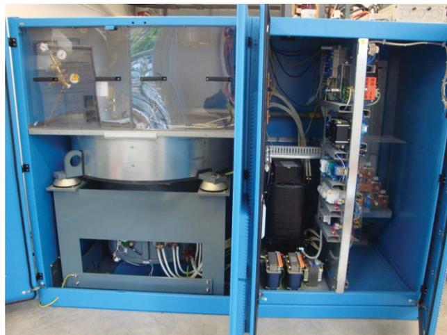
Abbildung 3-1: Schwungmassenspeicher Pb6 der Fa. Piller am EFZN (600 kW für 10 s). Auf der rechten Seite befindet sich im Wesentlichen die Wechselrichtereinheit, links ist die Schwungmasse mit dem auf der gleichen Achse befindlichen Generator zu erkennen.
