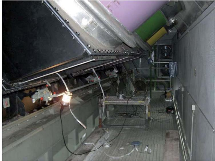
Abb. 6.9: Eingehauste US-Anschlüsse eines 750-MVA-Maschinentransformators während der Messung der Übertragungsfunktion
