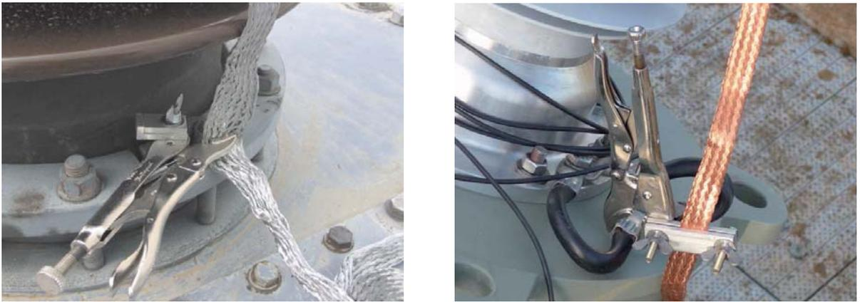
Abb. 6.25: Geeignete Kontaktierung mit dem Transformatorkegel
