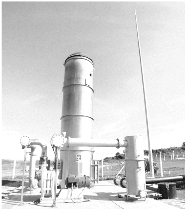
Figura 1 – Flare enclausurado em aterro sanitário da Companhia Riograndense de Valorização de Resíduos (CRVR) em São Leopoldo – Rio Grande do Sul
