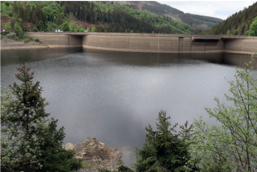
Abbildung A3-16: Staubauwerk der Okertalsperre
