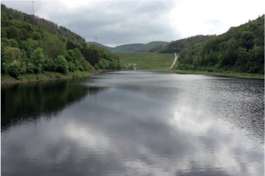
Abbildung A3-1: Staubauwerk der Odertalsperre (Luftseite)
