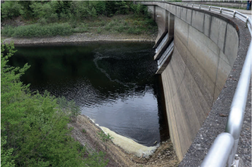
Abbildung A3-13: Staubauwerk der Vorsperre der Okertalsperre
