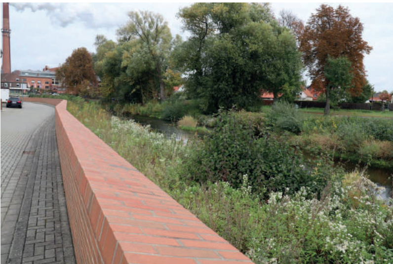
Abbildung 91: Hochwasserschutzmauer in der Ortslage Schladen
