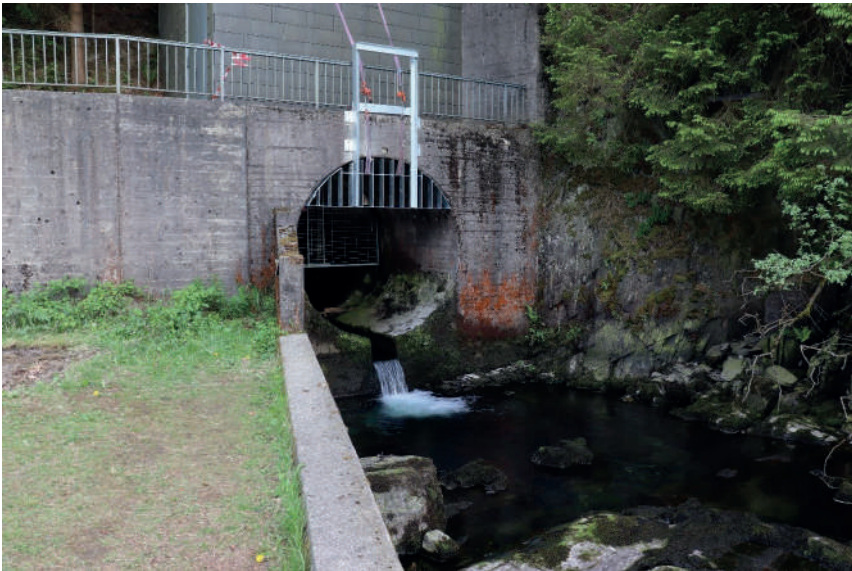
Abbildung A3-24: Auslauf des Oker-Grane-Stollen
