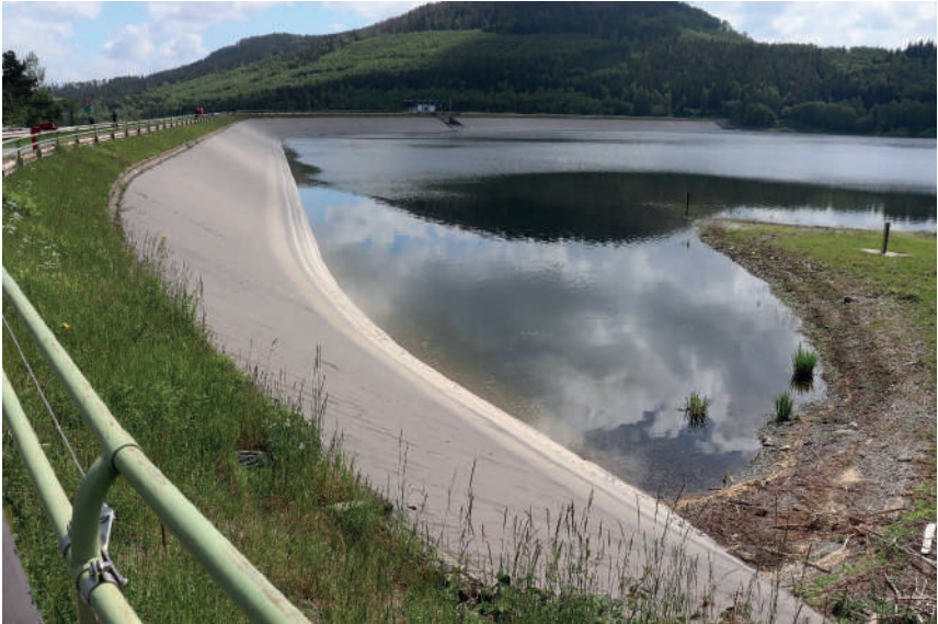
Abbildung A3-21: Staudamm der Granetalsperre
