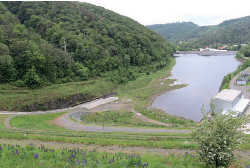
Abbildung A3-4: Unterwasserbecken der Odertalsperre mit Schussrinne
