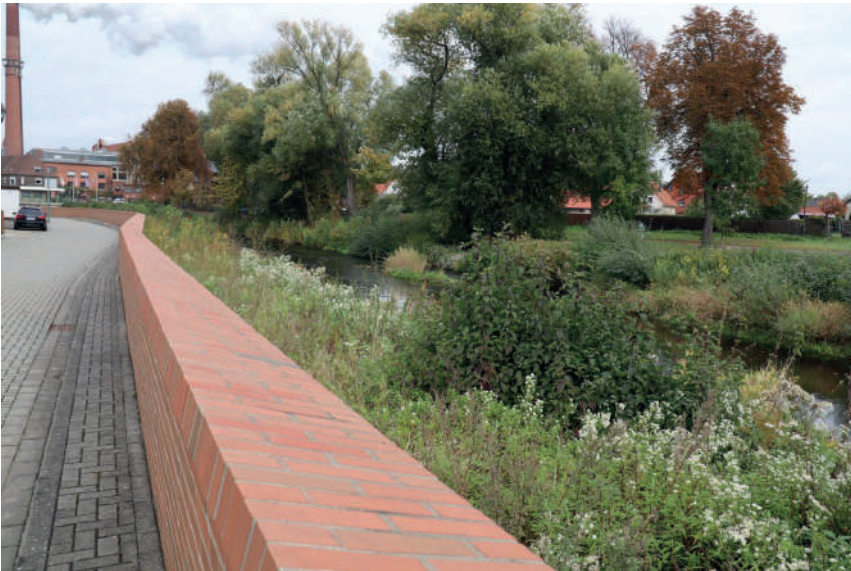
Abbildung A3-28: Hochwasserschutzmauer an der Oker in Schladen (Blickrichtung flussabwärts)
