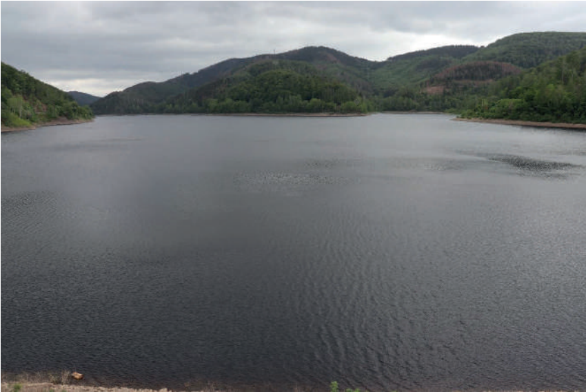
Abbildung A3-3: Odertalsperre (Blick gen Stöberhai und Herzbek)
