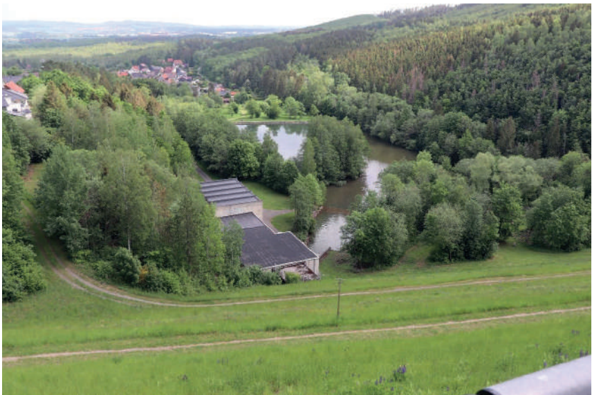
Abbildung A3-22: Unterwasserbecken der Granetalsperre
