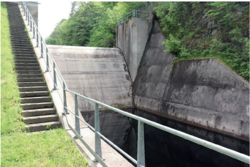
Abbildung A3-2: Überlauf Unterwasserbecken der Odertalsperre
