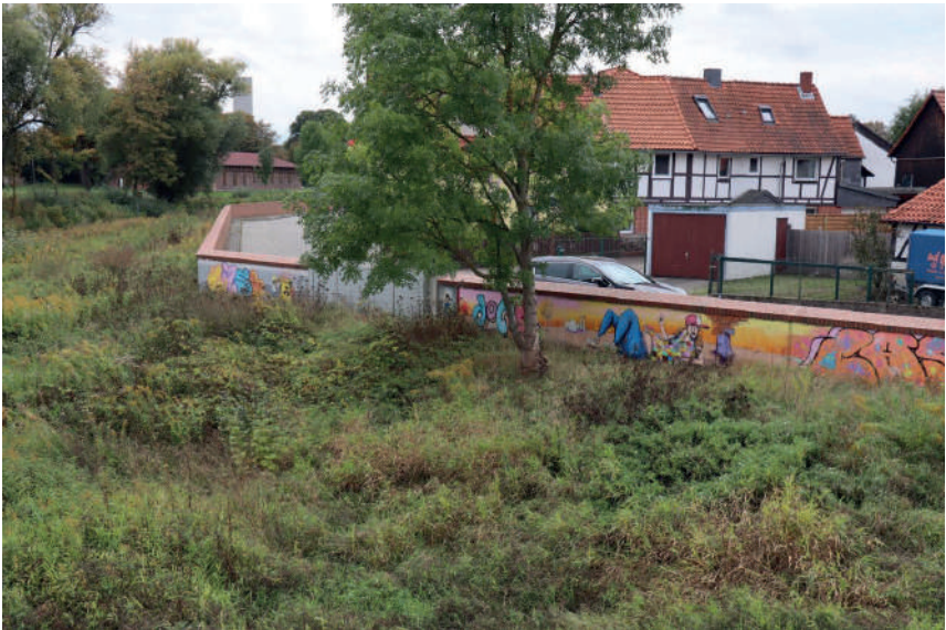
Abbildung A3-26: Hochwasserschutzmauer in der Ortschaft Schladen
