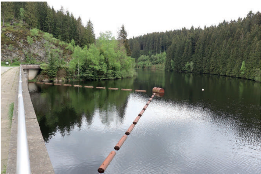
Abbildung A3-14: Vorsperre der Okertalsperre
