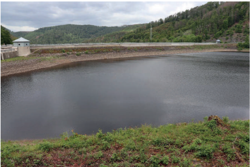
Abbildung A3-6: Blick auf das Staubauwerk der Odertalsperre (Wasserseite)
