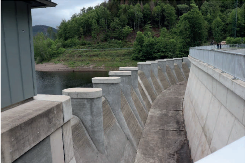
Abbildung A3-5: Wehrüberlauf der Hochwasserentlastung an der Odertalsperre
