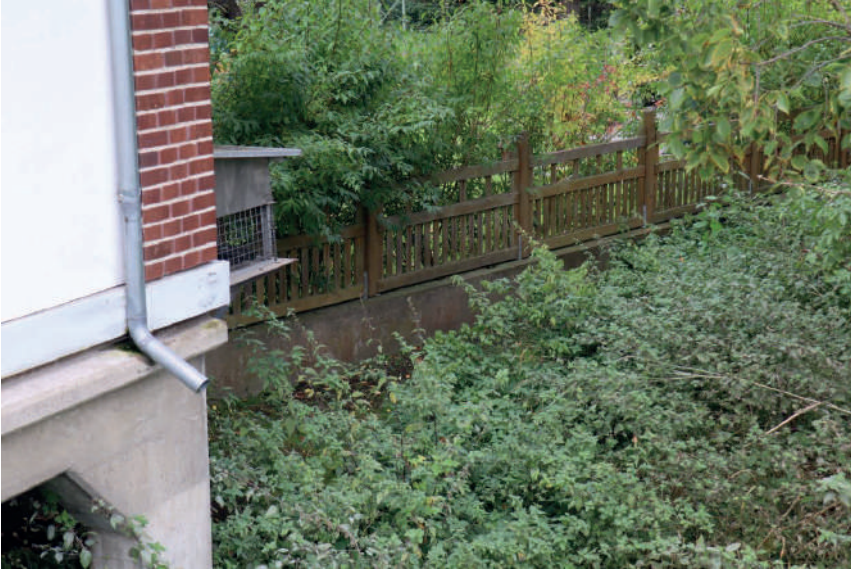
Abbildung A3-27: Hochwasserschutzmaßnahme in der Ortschaft Schladen
