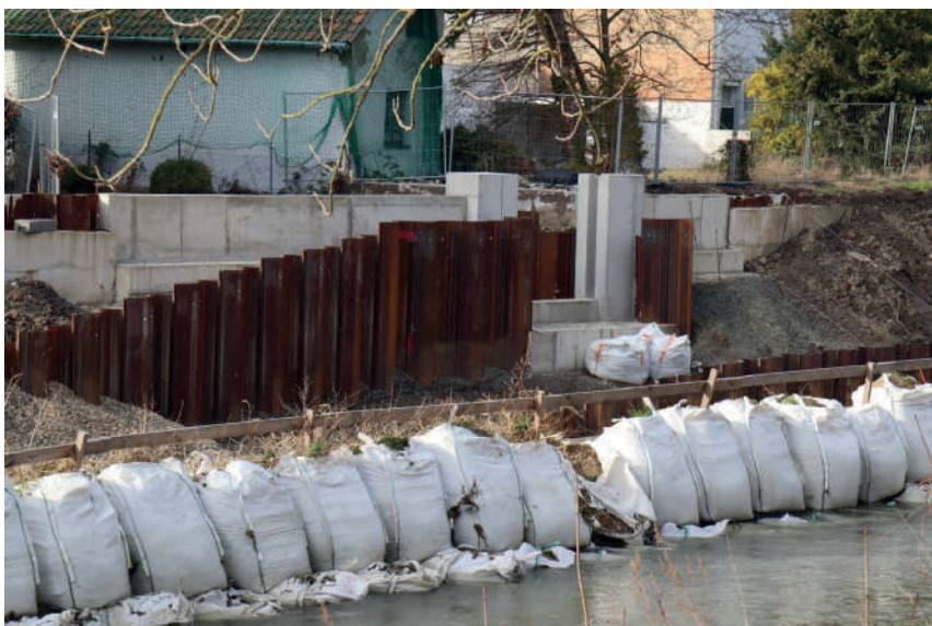
Abbildung A3-37: Hochwasserschutzmaßnahme "Bleichestraße" in Hildesheim
