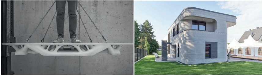
Abb. 2. Links: Topologieoptimiertes, digital an der ETH Zürich gefertigtes Deckenelement (aus [8]); Rechts: Erstes 3D-gedrucktes Haus in Deutschland (Bildquelle: www.baunetz.de ).
