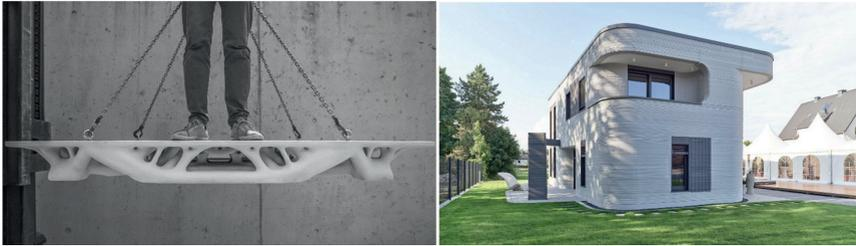
Abb. 2. Links: Topologieoptimiertes, digital an der ETH Zürich gefertigtes Deckenelement (aus [8]); Rechts: Erstes 3D-gedrucktes Haus in Deutschland (Bildquelle: [www.baunetz.de](http://www.baunetz.de)).
