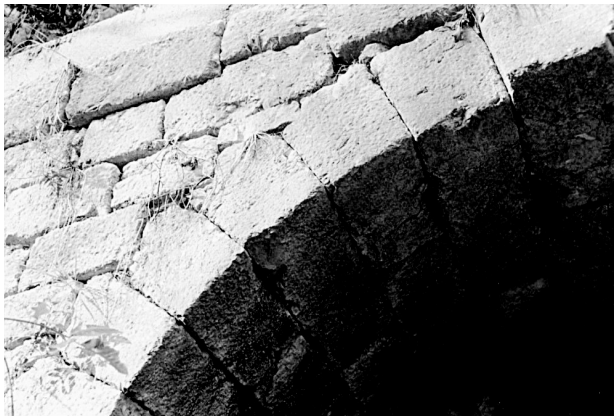
Abbildung 1: Bogenbrücke Soleleitungsweg, Quadermauerwerk (Foto Idam 2001)
