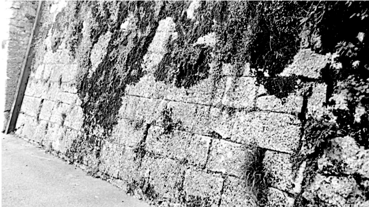
Abbildung 4: Stützmauer Hallstatt, Mortonweg (Foto Idam 2001).
