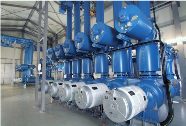
Abbildung 2.1.: 420 kV Gasisolierte Schaltanlage der EnBW Transportnetze AG in Metzingen, Deutschland (Mit freundlicher Genehmigung EnBW Transportnetze AG und ABB Schweiz AG)
