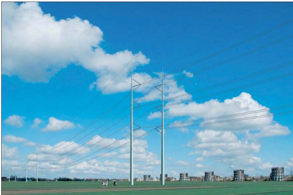
Abbildung 1.5 Sondermaste beim Wintrack-Projekt [5]
