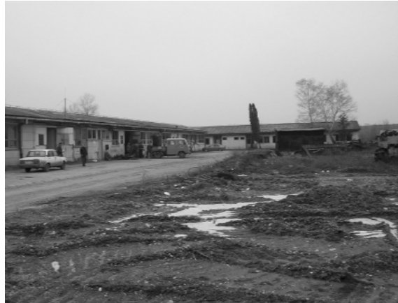
Abbildung 5 Zukünftiger „Einfahrtsbereich“ mit Bauwerksresten (früher von Bergwerksbetrieb genutzt)
