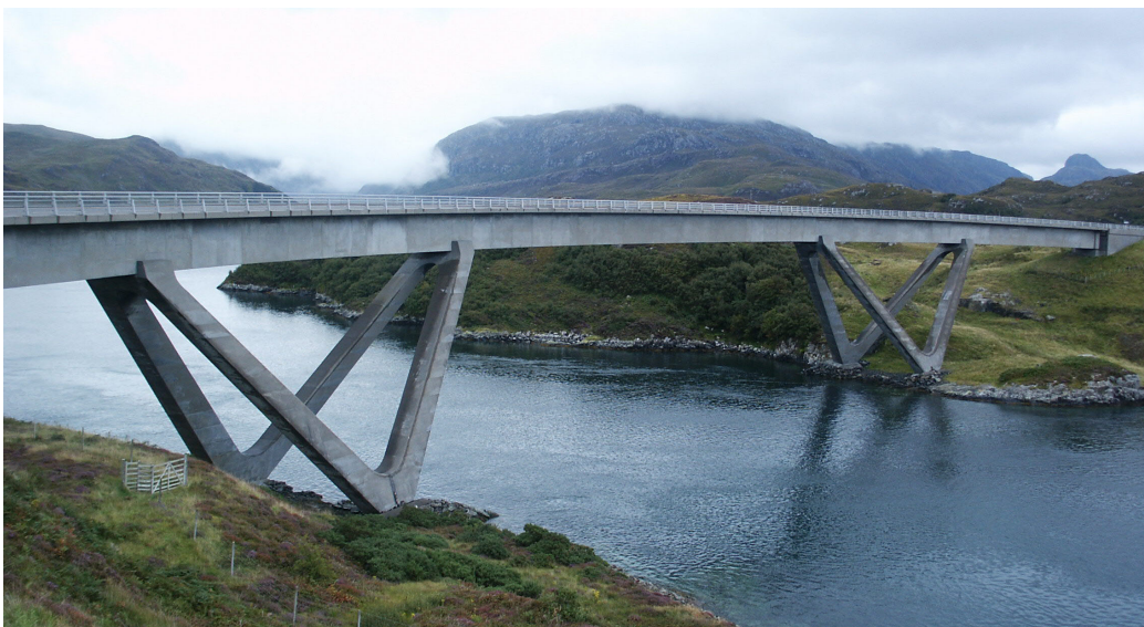
Bild 1.2 Kylesku-Brücke, Schottland, Entwurf Ove Arup & Partners, Fertigstellung 1984, monolithische Verbindung der V-förmigen Stützen mit dem Überbau
