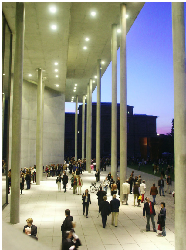
Bild 1.1 Pinakothek der Moderne, München, Schleuderbetonstützen mit \lambda \approx 150
